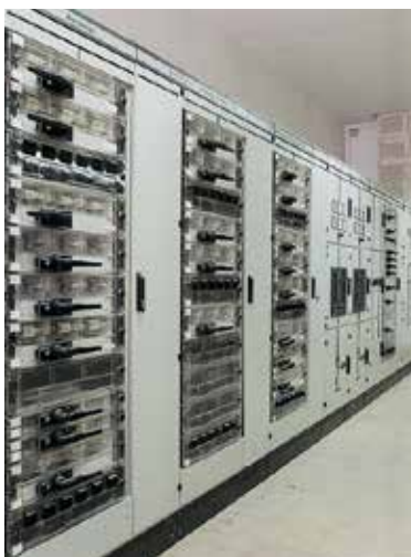
03 Energieschaltgerätekombination aus Stahlblech (links) und aus Isolierstoff
